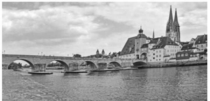
Die Steinbogenbrücke von Regensburg ist die älteste erhaltene Brücke Deutschlands und eine der größten technischen Leistungen des Mittelalters. Mit einer Länge von 310 m überspannt sie mit 14 Rundbögen gleich zwei Arme der Donau. Die Bauzeit betrug nur 11 Jahre, von 1135 bis 1146. Die Steinbogenbrücke von Regensburg war mehrere Jahrhunderte die einzige Donaubrücke zwischen Ulm und Wien.
