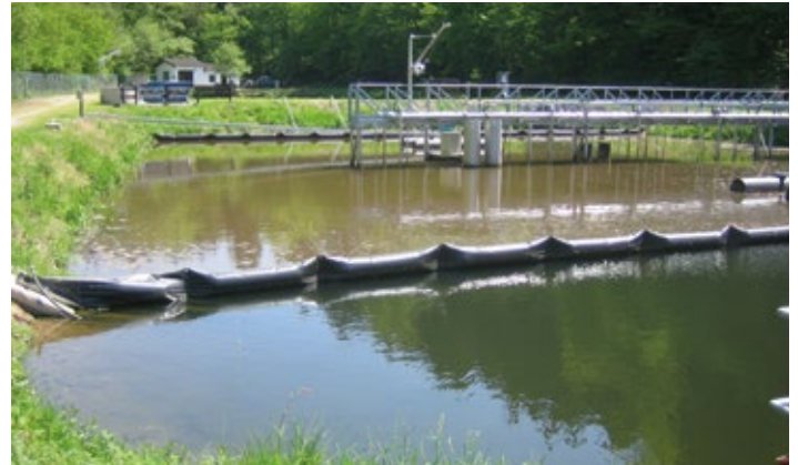
Kläranlage im Fockenbachtal bei Straßenhaus
