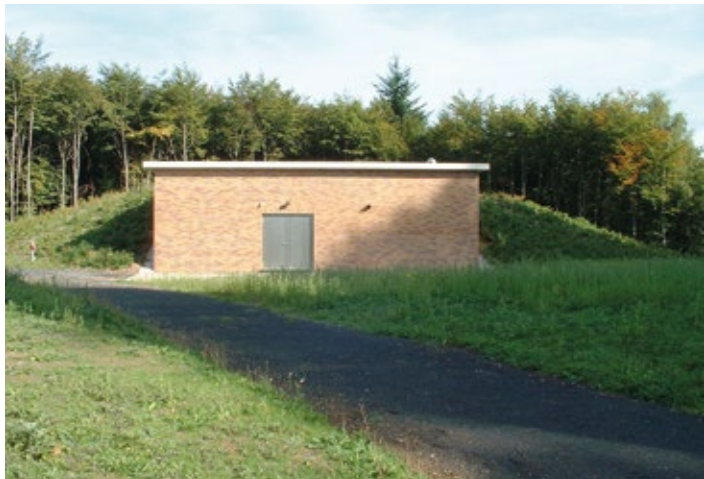
Hochbehälter in Rengsdorf
